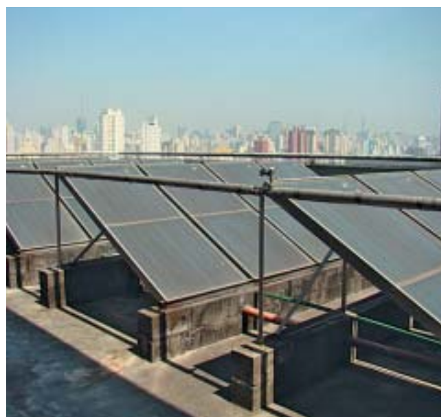
Foto: coletores solares Torre 1- Mundo Apto Cambuci
