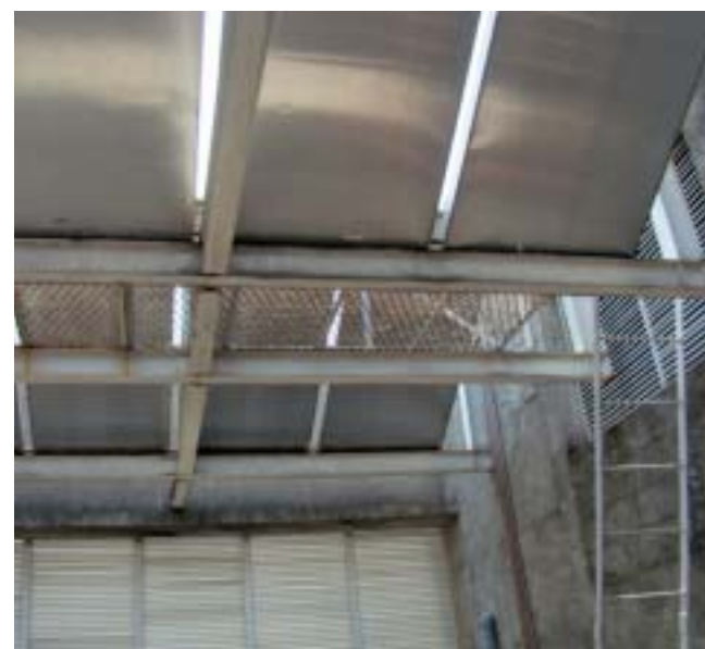
Escadas que levam às passarelas de acesso aos coletores solares garantem a acessibilidade ao sistema
