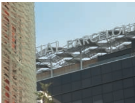
Captadors solars integrats en la pèrgola d'un hotel
