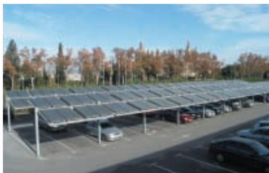
Central solar com a pèrgola d'un aparcament
