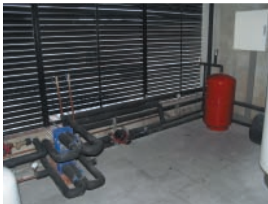
Sala d'acumuladors d'una instal·lació solar tèrmica
